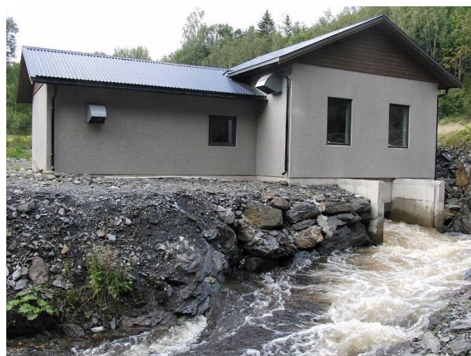
Figur 1 Grønningseelva kraftverk i Levanger kommune er et typisk småkraftverk med installert effekt rett under 1 MW. Kraftverket har en forventet årsproduksjon på 2.8 GWh.
