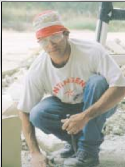
Bygningsarbeider under rehabilitering av fagforeningskolen Lazareno Pená. Foto: Terje Kalheim
